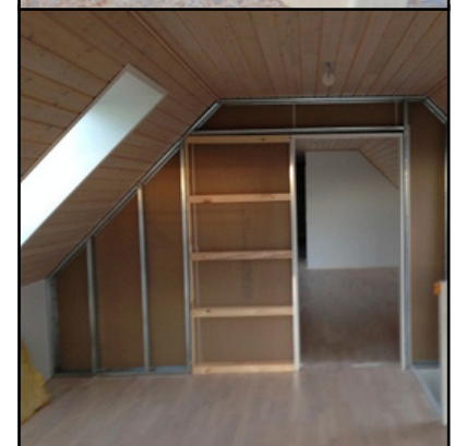
Karmen er klar til montering af gipsplader
